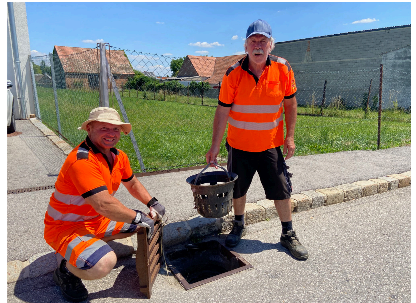
Die Außendienstmitarbeiter reinigen regelmäßig die Kanalschächte.
